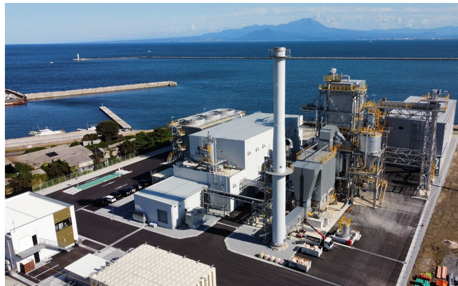
境港バイオマス発電所全景
