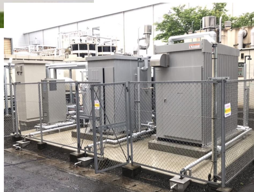
水素事業P2Gシステム利用設備
