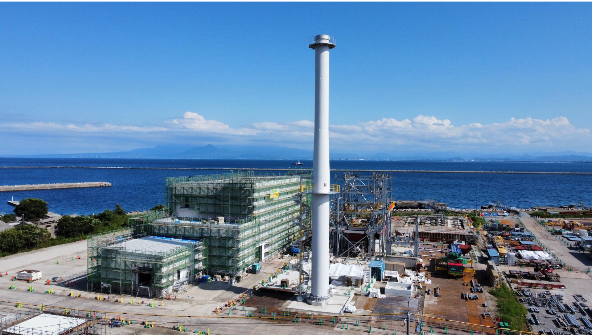
境港バイオマス発電所（施工中）
