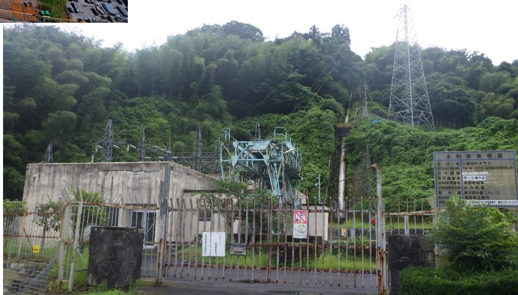
鳥取県営水力発電所再整備事業
