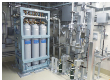
東北電力(株) 女川原子力発電所2号機 ガス消火設備
