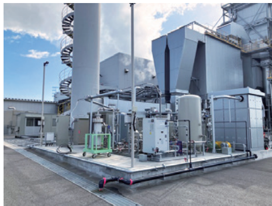
境港バイオマス発電所構内 CO2分離試験設備（鳥取県境港市）
