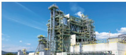
日向バイオマス発電所（宮崎県） 2024年10月16日運転開始 出力規模：50,000kW
