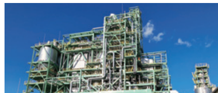
田原バイオマス発電所（愛知県） 2025年4月1日運転開始 出力規模：50,000kW
