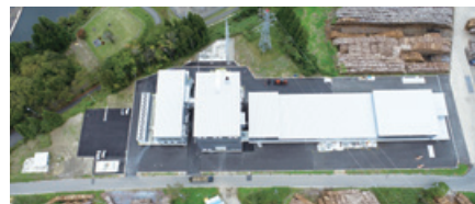
会津こもれびバイオマス発電所（福島県） 2024年12月1日運転開始 出力規模：7,100kW
