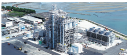
長府バイオマス発電所（山口県） 2024年12月30日運転開始 出力規模：74,950kW
