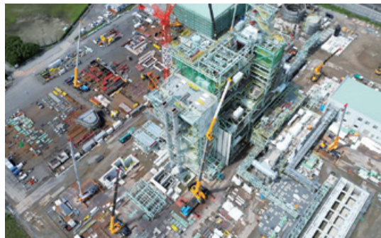
2024年の営業運転にむけて建設中
