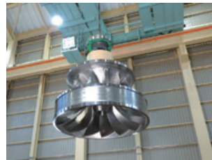
リパワリング工事により、最大出力3号機ランナ吊り込み作業は400kW増の11,000kWを実現
