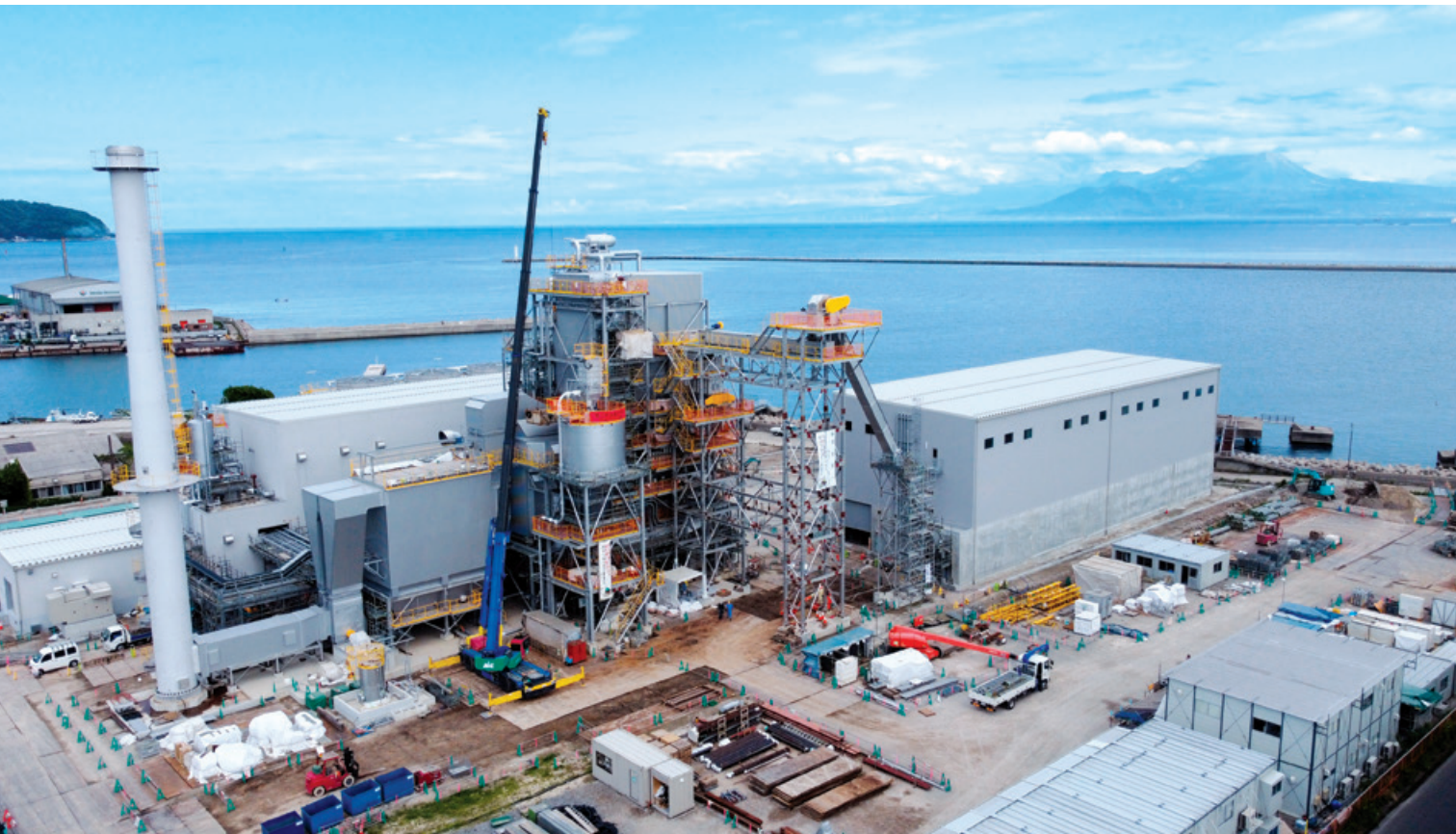
境港バイオマス発電所（建設中）
