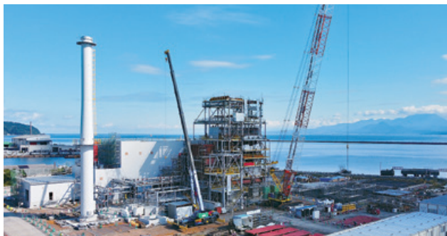
高さ40メートルの煙突が完成し、発電所の様相を呈してきました。
