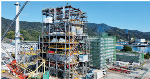
建設工事の様子（ボイラー）2021.10.26現在
