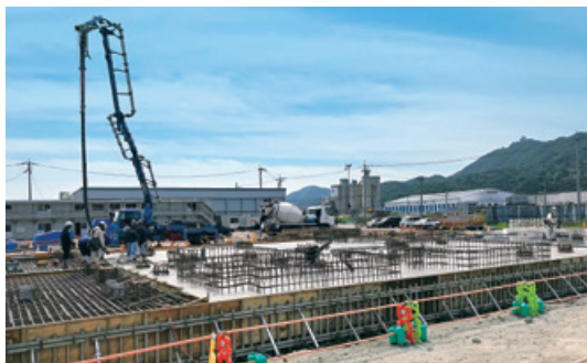
ボイラー基礎工事
