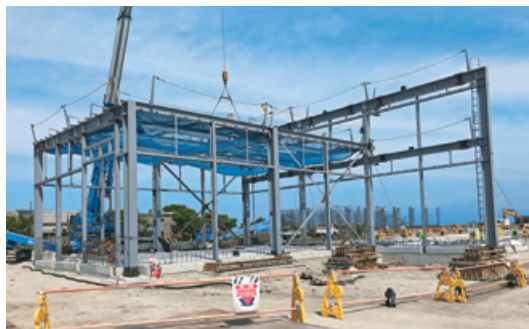
冷却塔鉄筋工事
