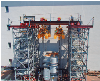
地下空間からの吊り上げ作業（変圧器：重量60t）
