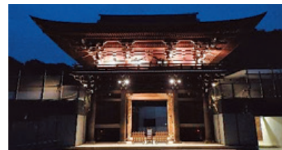
美観に配慮した照明（南神門）
