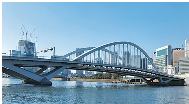
築地大橋の全景
