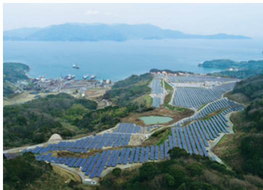
大規模太陽光発電所（山口県、12,260kW）
