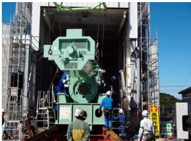
工場向け発電機搬入作業
