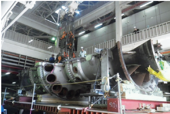
ガスタービン点検作業
