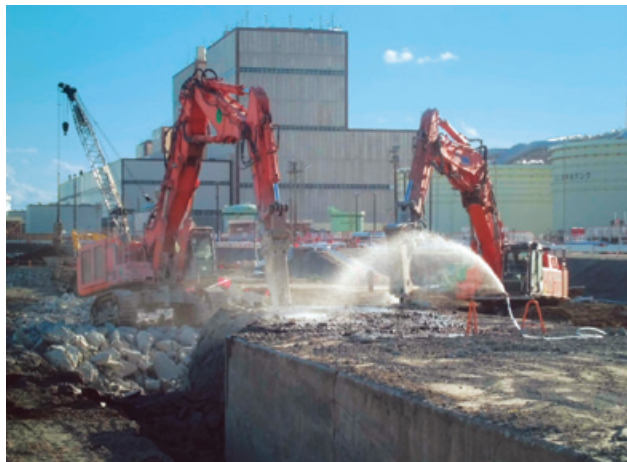
オイルタンク撤去工事
