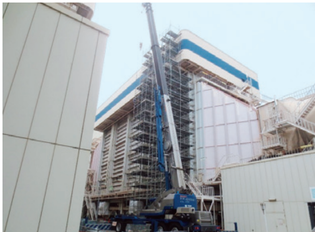
低圧節炭器パネル取替工事
