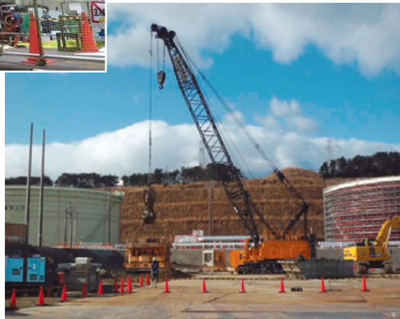
タンク撤去工事
