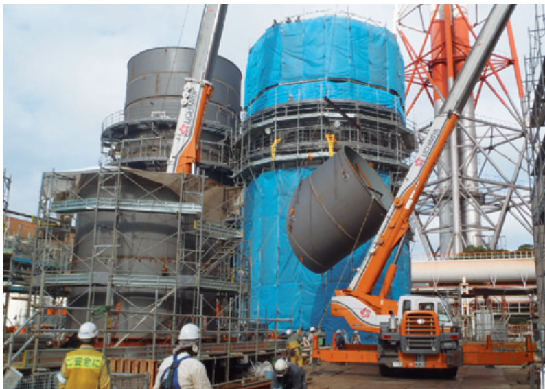
環境設備建設工事
