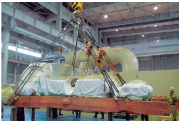
タービン設備定期点検手入工事（高圧タービン分解作業）
