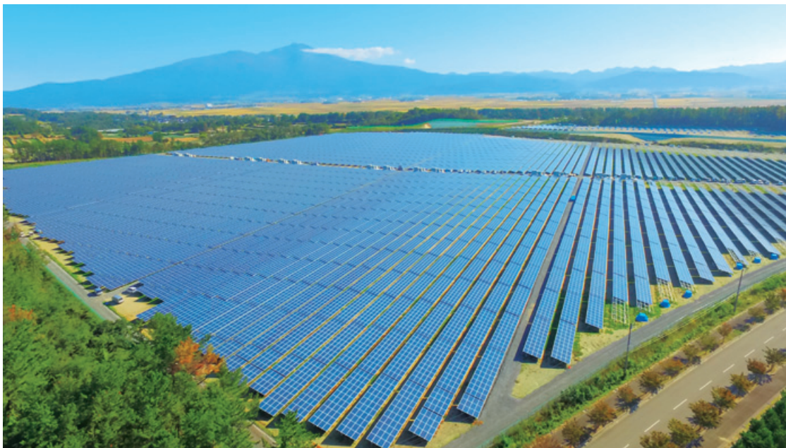
山形県遊佐町太陽光発電設備建設工事 パネル出力24MW (工期 平成26年6月～平成27年12月)
