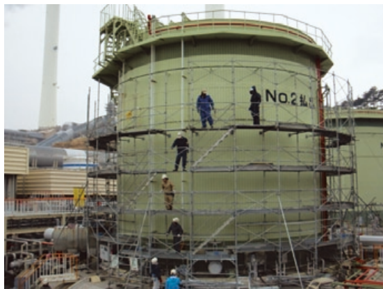
東京電力(株)広野火力発電所 払出タンク点検
