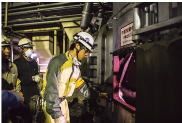
東京電力(株)広野火力発電所 給炭機、微粉砕機点検
