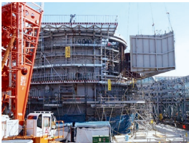
常陸那珂火力発電所 脱硫設備据付
