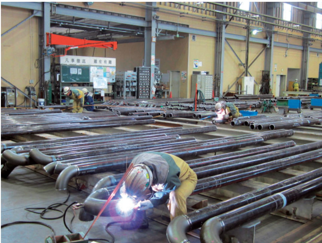
東京電力株式会社千葉火力発電所 3号系列ガスタービンの コンバインドサイクル化工事で使用する配管類の溶接作業
