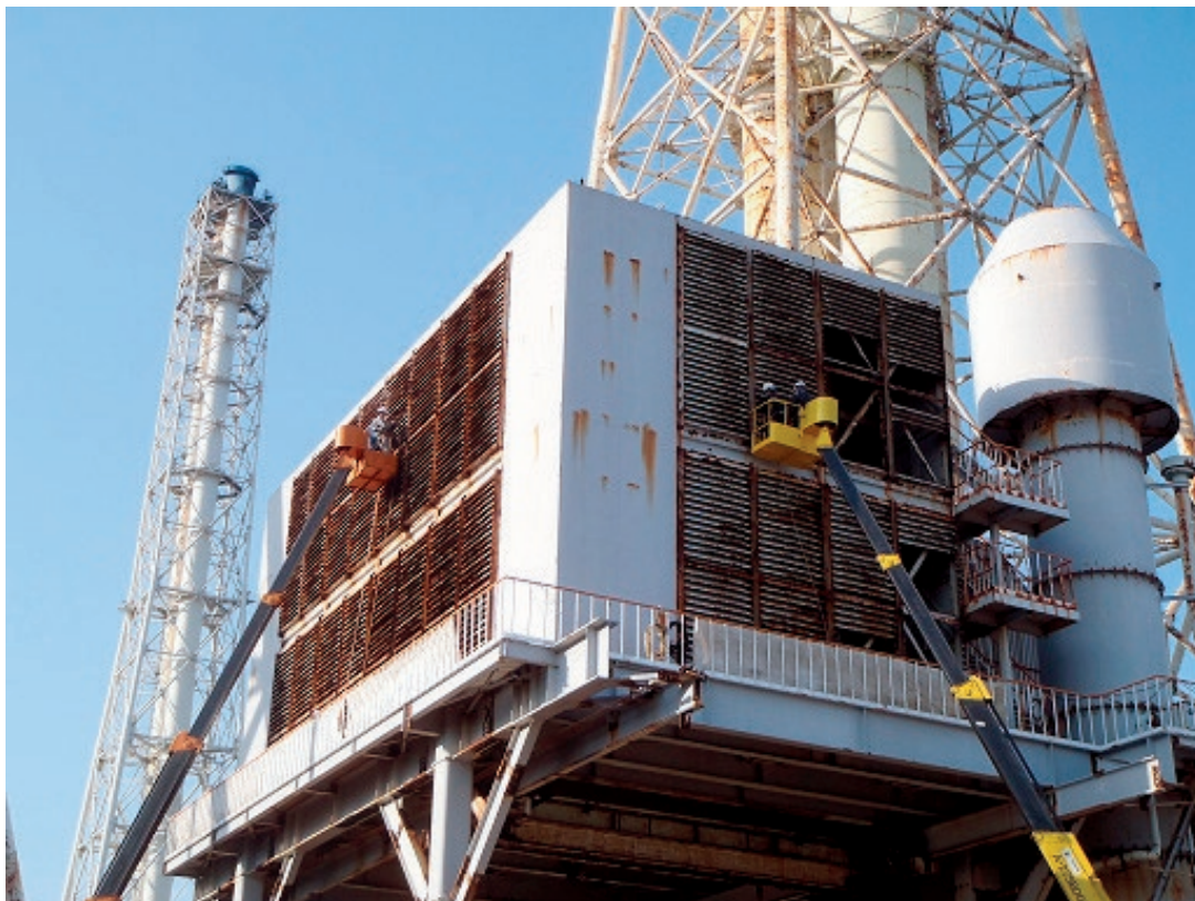
東京電力㈱横須賀火力発電所 2号ガスタービン修理工事 (ガスタービン吸気ルーバー修理)
