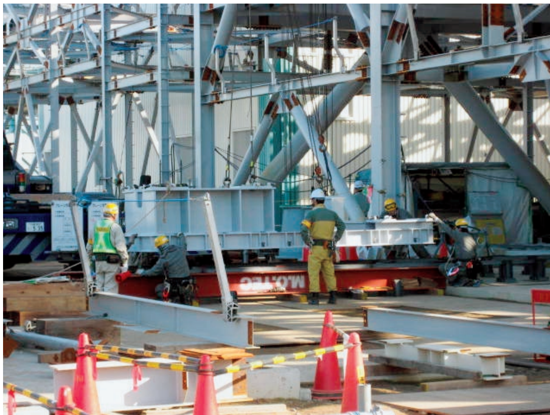
東京電力(株)常陸那珂火力発電所 2号機増設工事 (2号機脱硫・吸収塔循環ポンプベース搬入)
