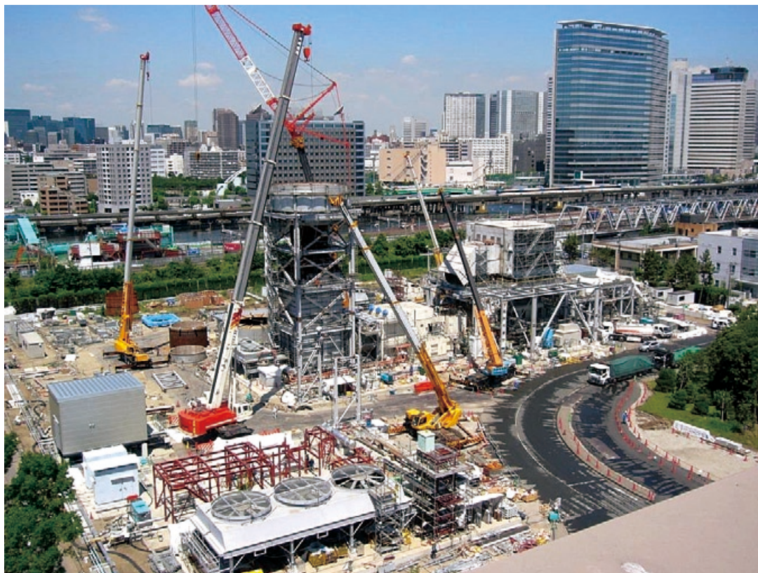
東京電力(株)大井火力発電所 ガスタービン設置工事
