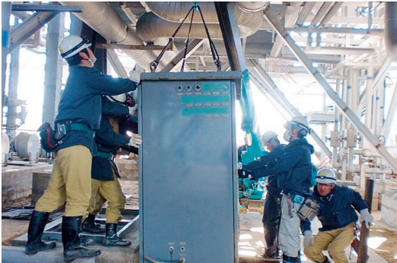
被災した発電所設備の 復旧工事
