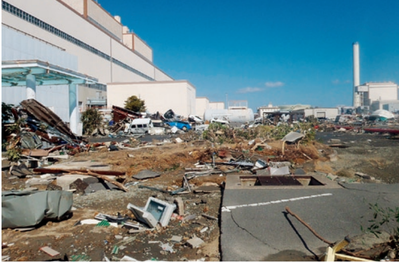
発電所構内の被災状況
