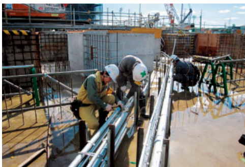
2号機の建設工事（電線管布設工事）
