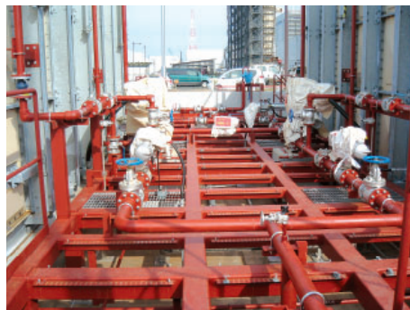
NSD（非放射性ストームドレン系）収集処理設備設置工事
