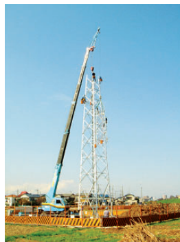
携帯電話基地局の建設工事
