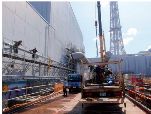
屋外消火栓配管設置工事
