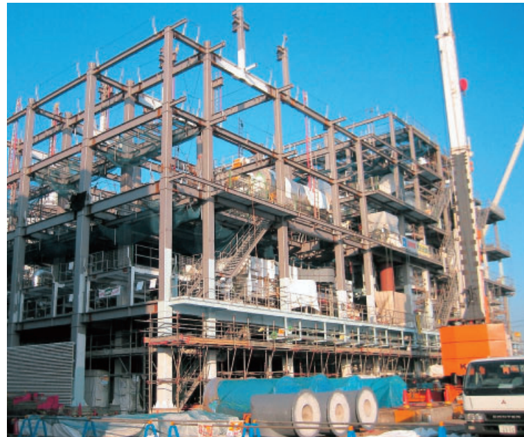
下水汚泥炭化設備建設工事
