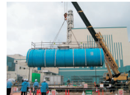
防火水槽据付
