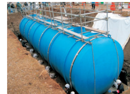
防火水槽埋設 容量：100トン
