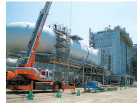
東京電力株式会社富津火力発電所 (4号系列発電設備建設工事)
