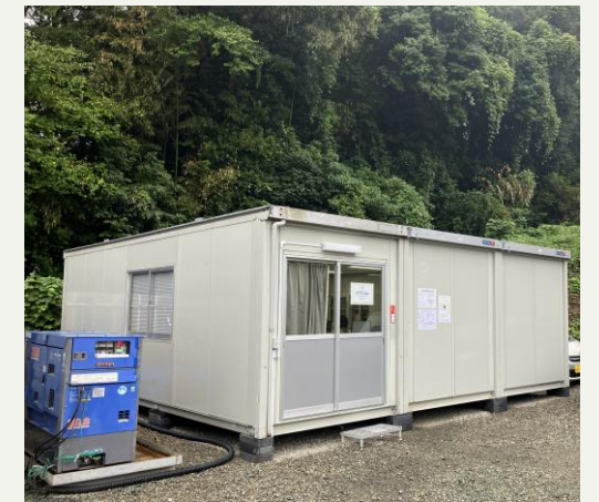
現地事務所の設置(2025年10月)
