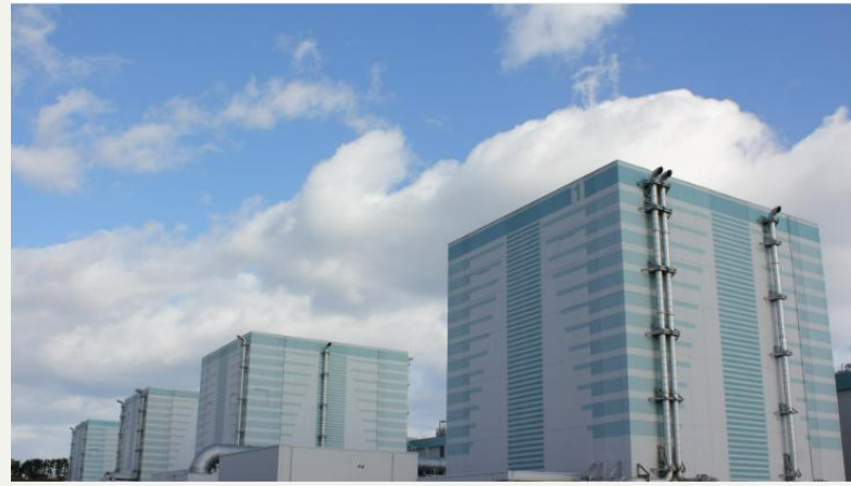
東京電力ホールディングス様 福島第二原子力発電所
