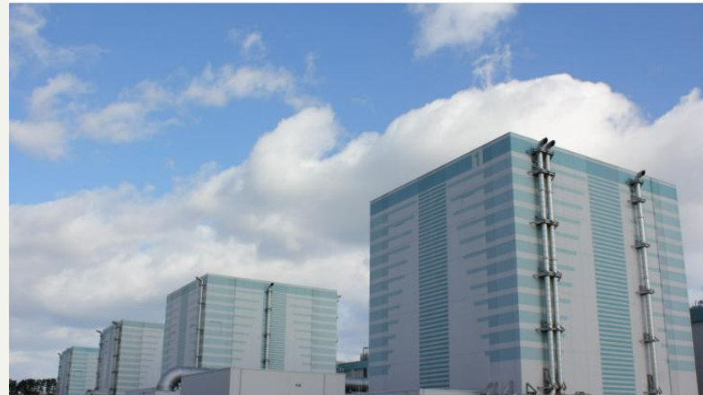
東京電力ホールディングス様 福島第二原子力発電所
