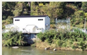
【日野川第一発電所】
