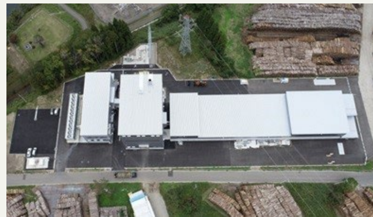
会津こもれびバイオマス発電所 2024年12月1日運転開始 出力規模：7100kW 受注内容：LTSA
