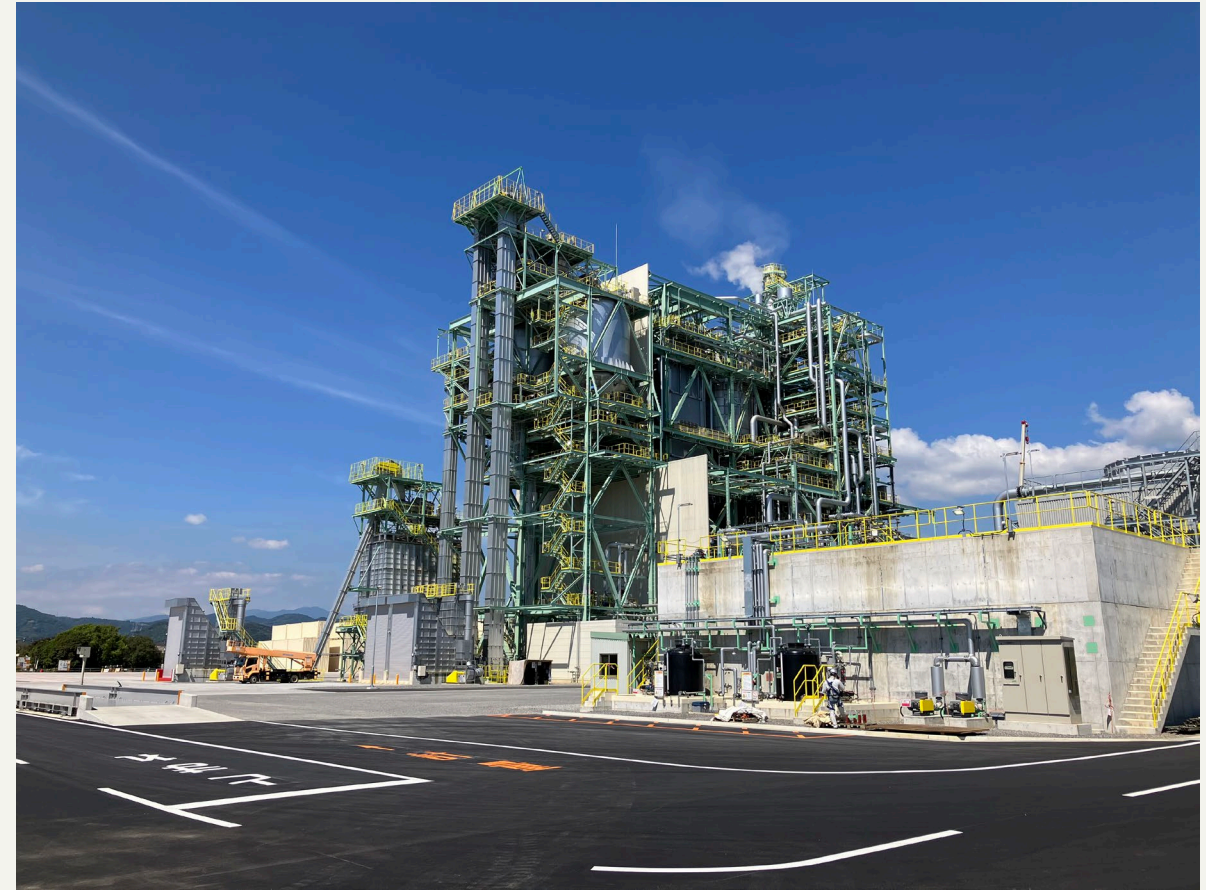
日向バイオマス発電所
