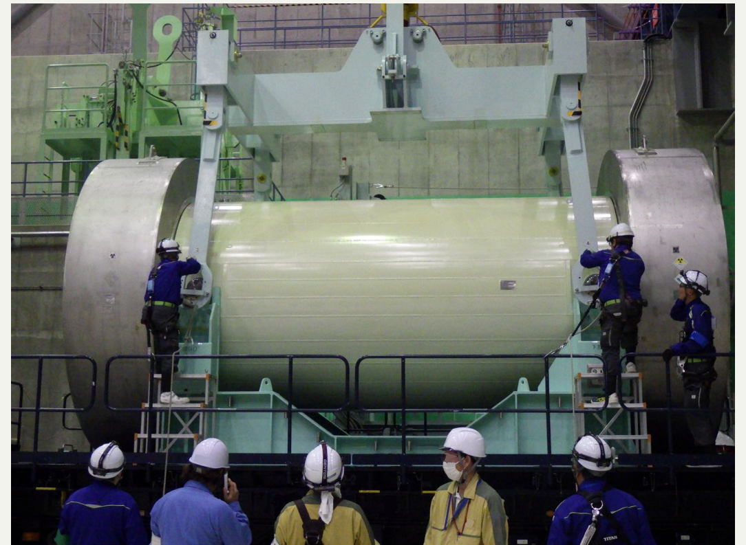
左：リサイクル燃料備蓄センター貯蔵建屋イメージ、右：貯蔵建屋内におけるトレーラーからの金属キャスクのつり上げ作業（リサイクル燃料貯蔵株式会社HPより）
