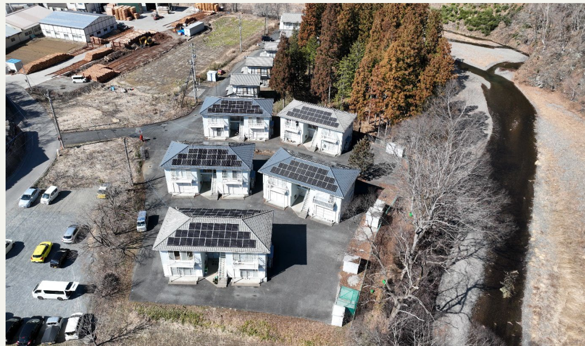
完成した村営住宅の太陽光発電設備
