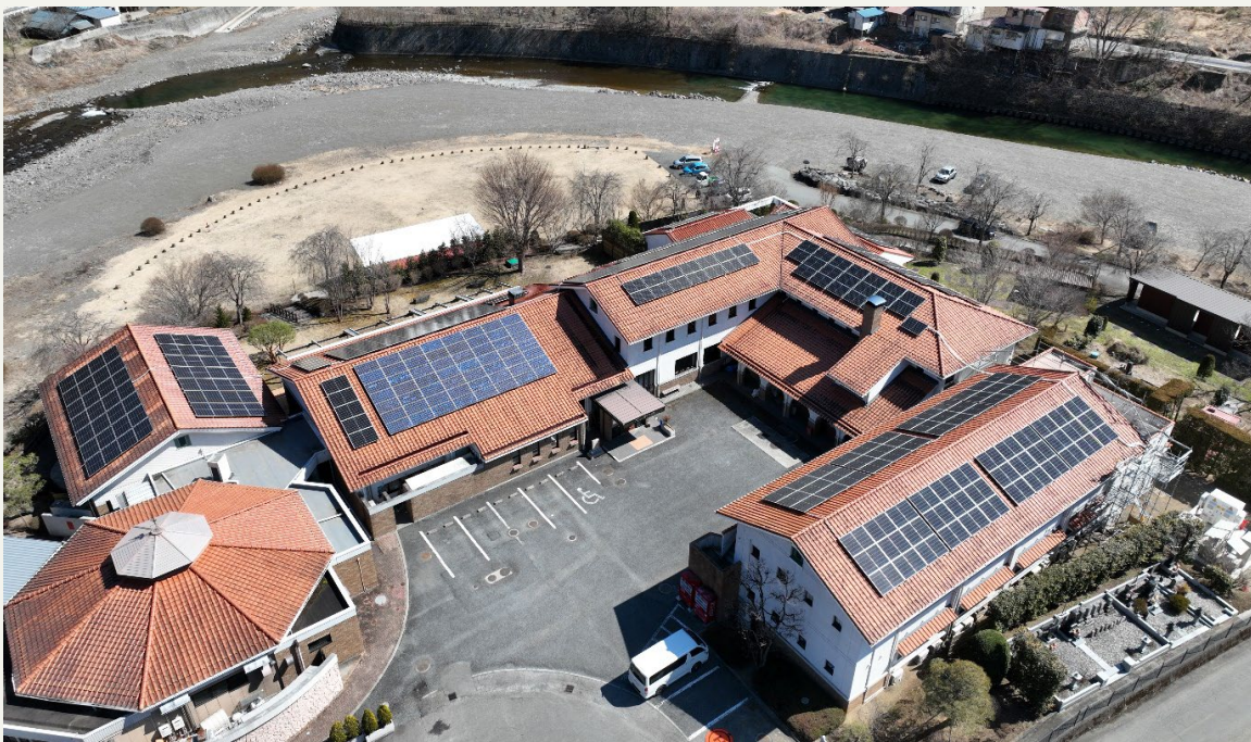
完成したヴィラせせらぎ（公共施設）の太陽光発電設備
