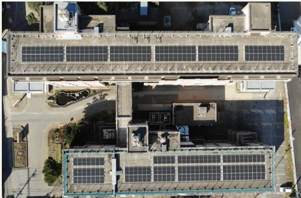
屋上太陽光設備 全景
