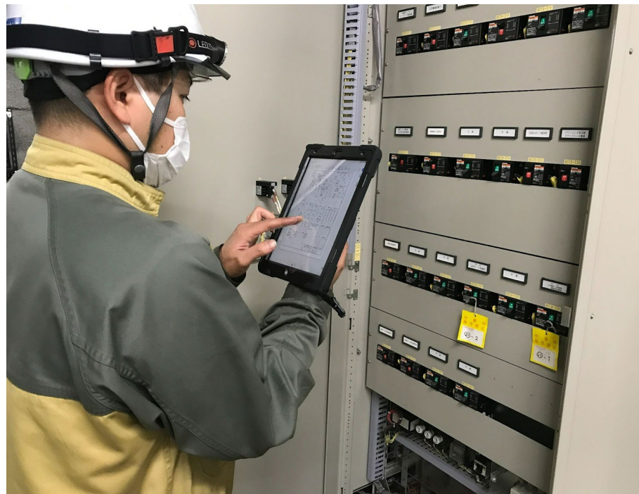
タブレットを使用したデータ確認の様子
