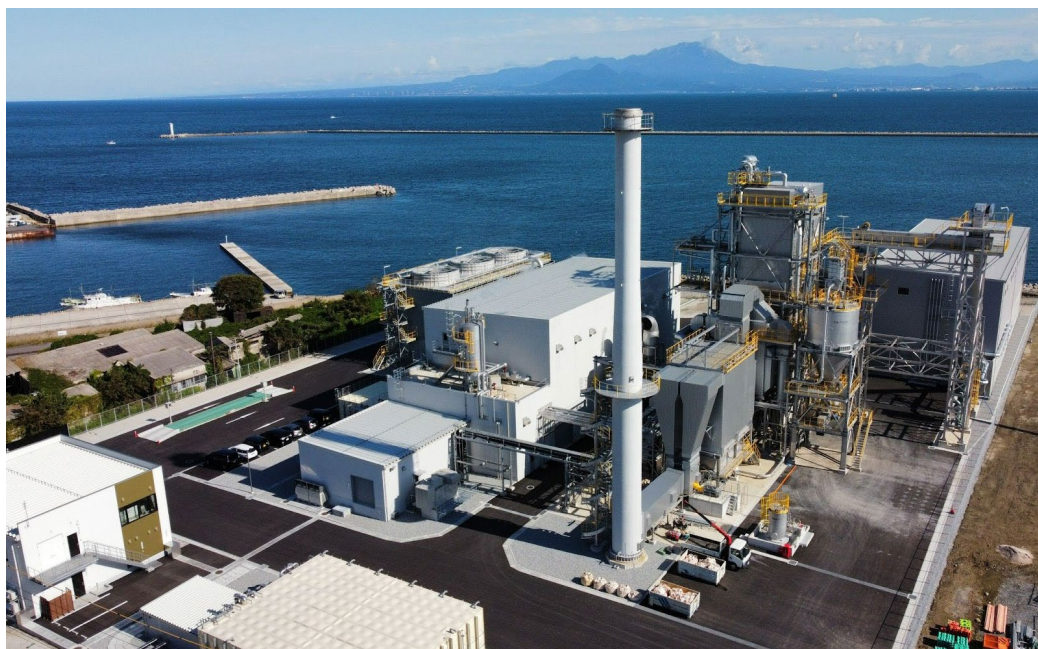
境港バイオマス発電所 全景
