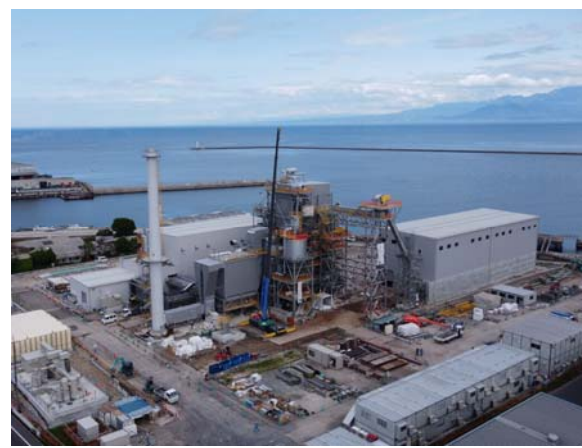
境港バイオマス発電所全景（建設中）
