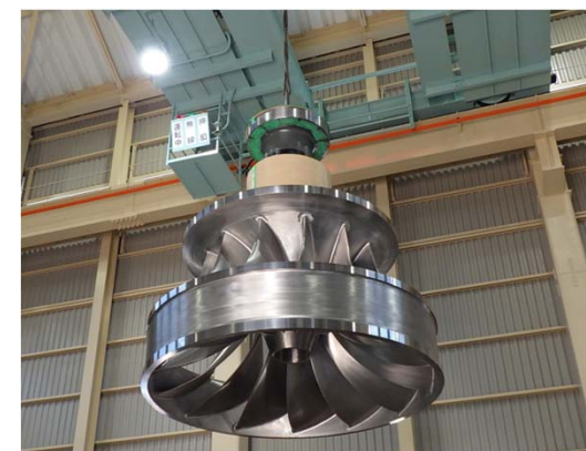
3号機ランナ吊り込み
