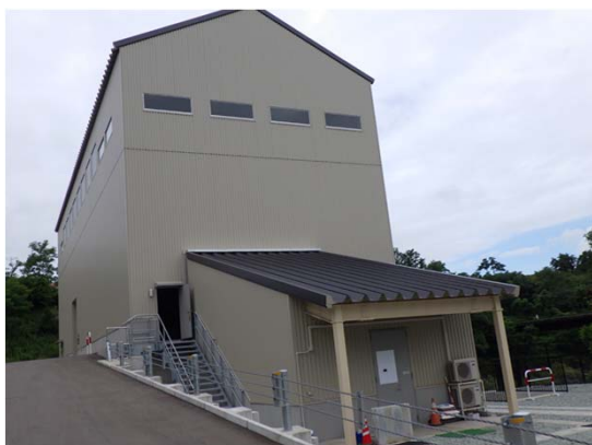
発電所建屋外観
