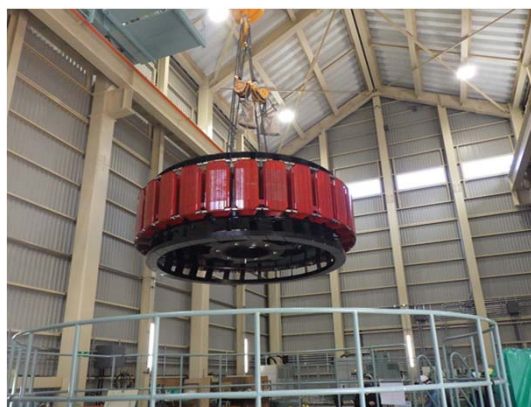
2号機ロータ吊り込み
