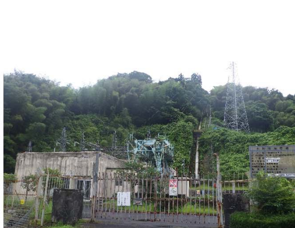
小鹿第二発電所
