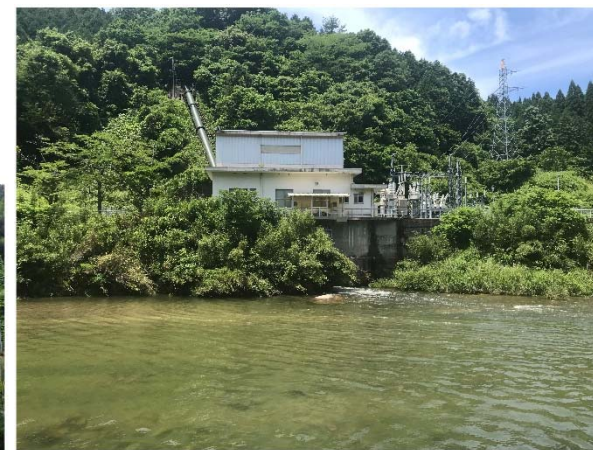
日野川第一発電所
